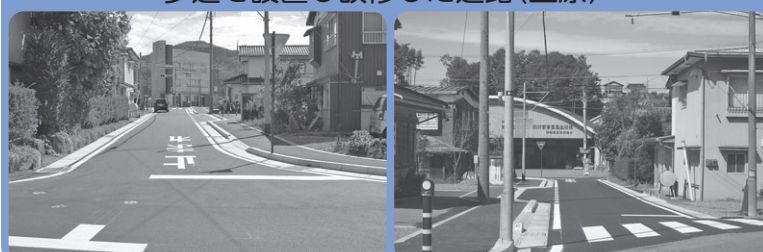
歩道を設置し改修した道路(上原)
