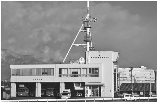
写真⑤ 改築を待つ伊那公民館と閉館の伊那市民会館
