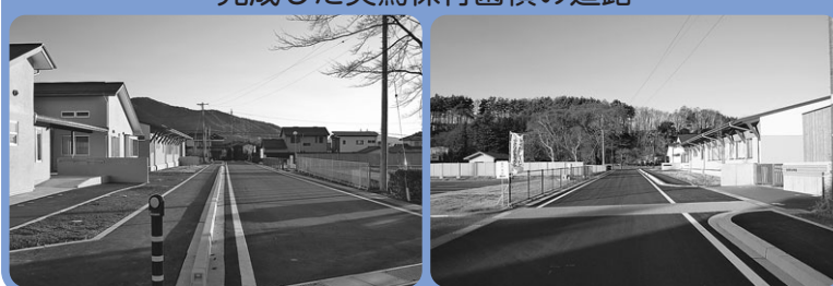
完成した美簗保育園横の道路
