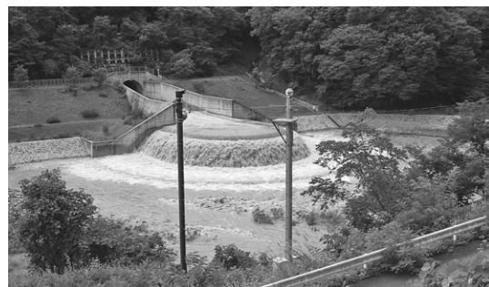
写真② 台風による大雨後の美和ダムバイパストンネルによる排水と監視カメラ
