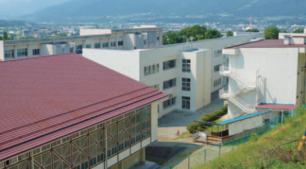
来年は工事の竣工とともに「開校50周年記念式典」を予定しています。
