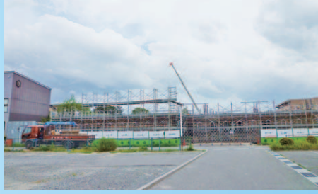
統合により新築工事が進む竜東保育園
