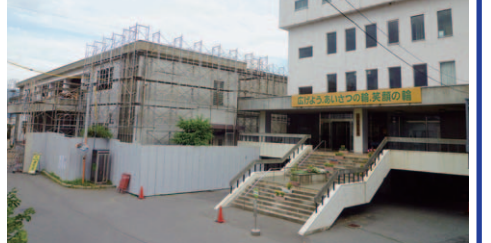
解体が始まった市民会館と改築が予定されている伊那公民館
