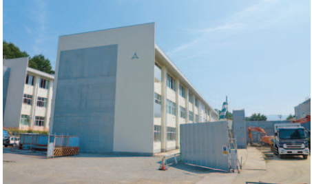
改築整備の進む「東部中」。総事業費は約15億円です。
